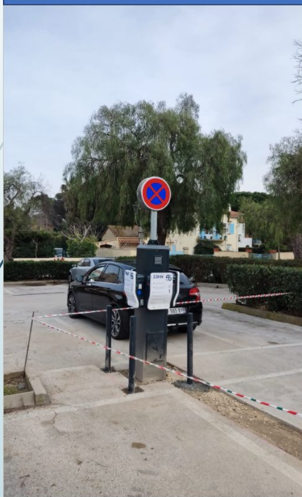
Pose de la borne sur massif candélabre
