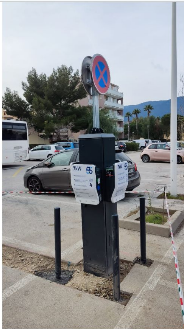
Pose de la borne sur massif candélabre
