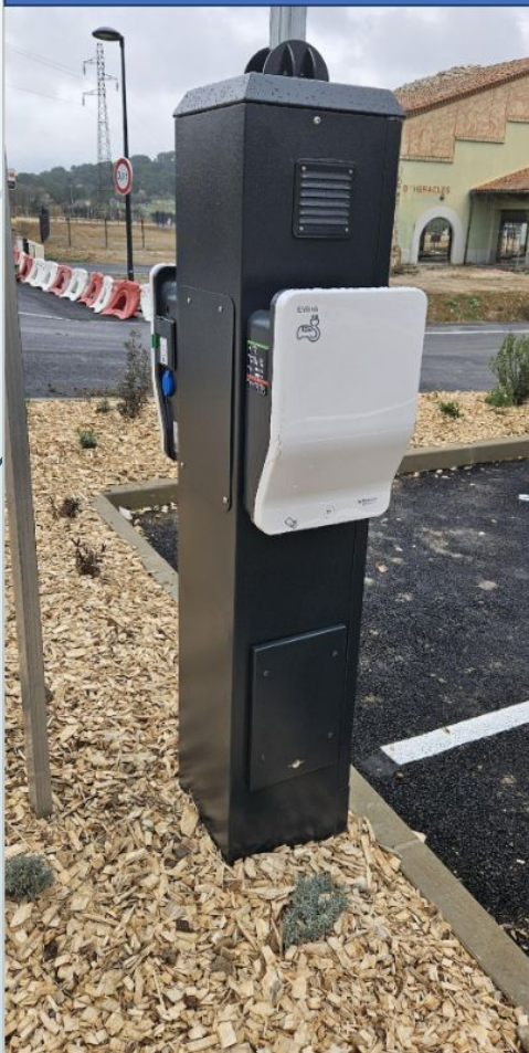
Pose de la borne sur massif candélabre
